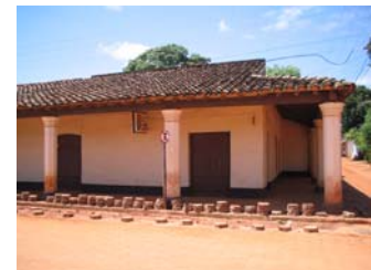
Viviendas antiguas con pilares de mampostería
