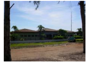
Edificio de ANDE
