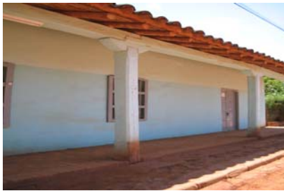
Vivienda antigua con pilares de madera
