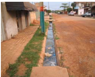
Canaleta a cielo abierto
