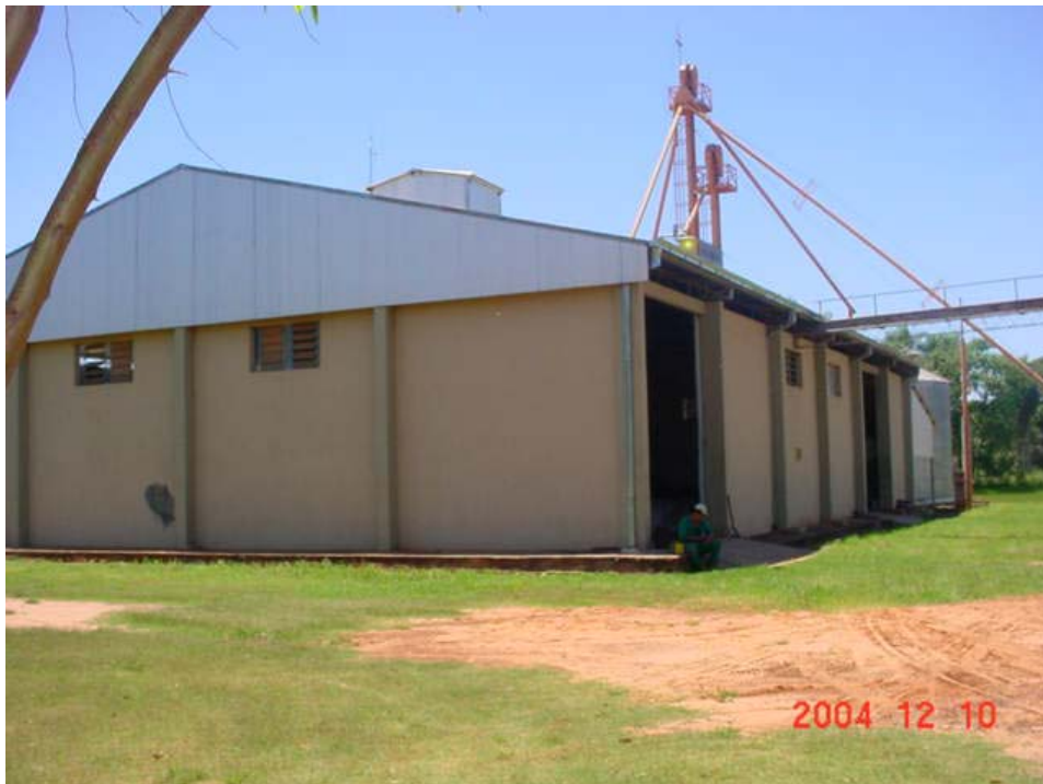
Silo de la Cooperativa La Norteña, ubicado a 3 km. de la ciudad
