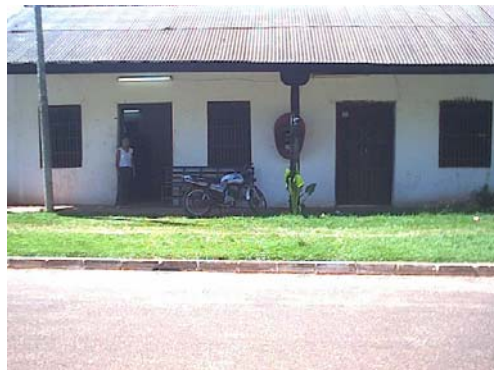
Local donde funciona COPACO
