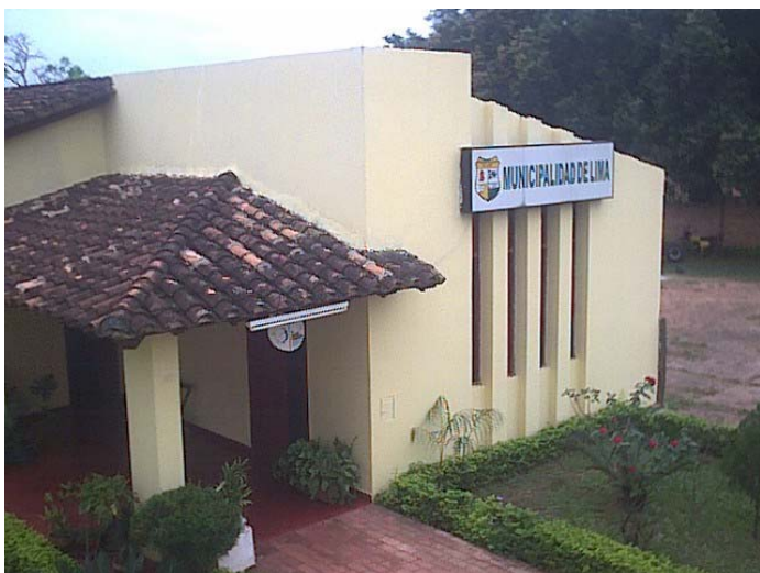
Fachada de la Municipalidad de Lima
